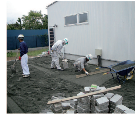
敷砂転圧・高さ調整
